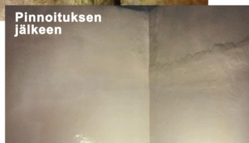
Pinnoituksia: savukaasuputki syöpymistä vastaan ja hakepurkaimen seinämät kerrostumien muodostumista (holvaantumista) ja kulumista vastaan.
