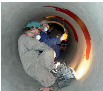
Pinnoituksia: savukaasuputki syöpymistä vastaan ja hakepurkaimen seinämät kerrostumien muodostumista (holvaantumista) ja kulumista vastaan.
