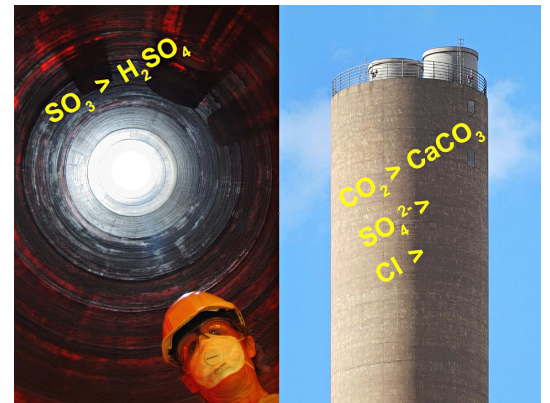
Piipun sisä- ja ulkopuolen kunnontarkastuksia
