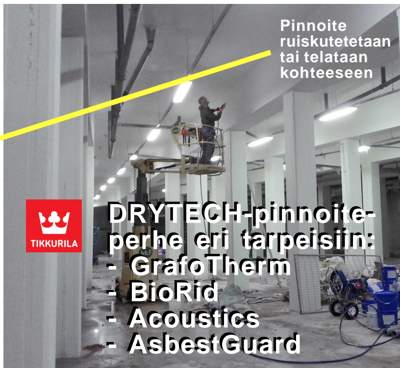
Kuvassa terminaalin sisäkaton antikondenssipinnoitus (yli 3000 m 2 ). Lopputuloksena vettä tippumaton ja esteettisesti kaunis tila.
