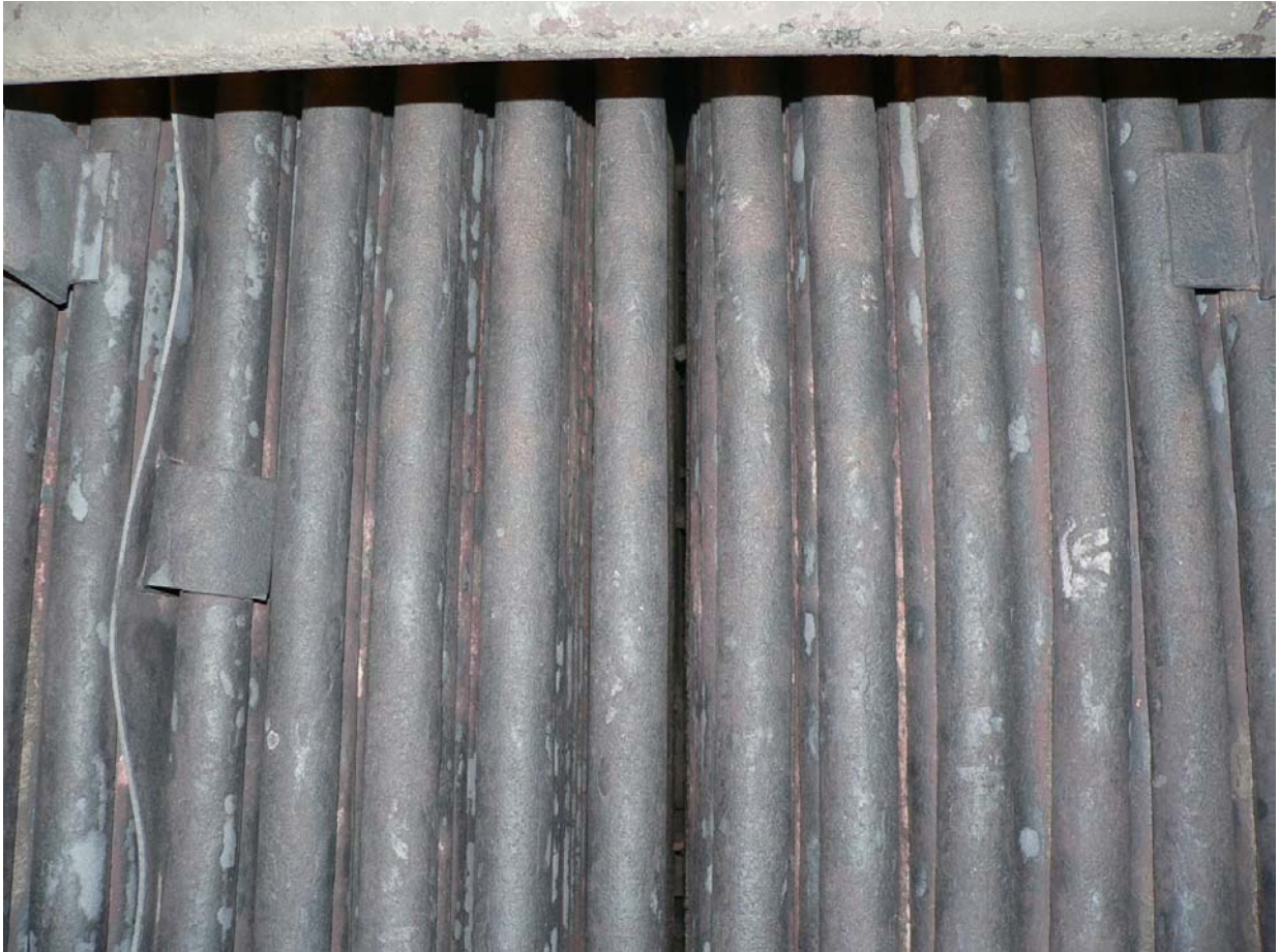
Lämmönvaihtimen puhtausaste hiekkapesun jälkeen.
